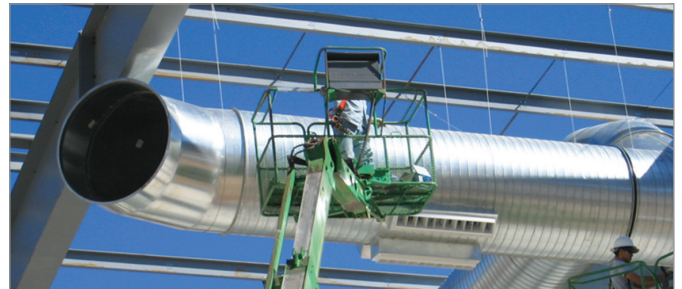
Gripple en la construcción
