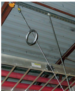
Tirantes para bandejas portacables
